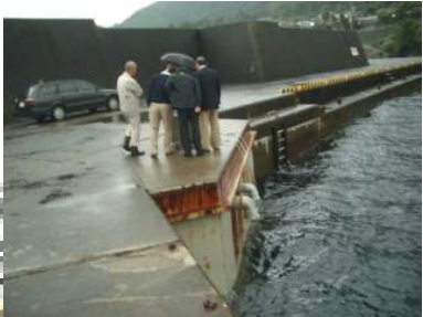
ポンプピット ポンプ毎時10トン
